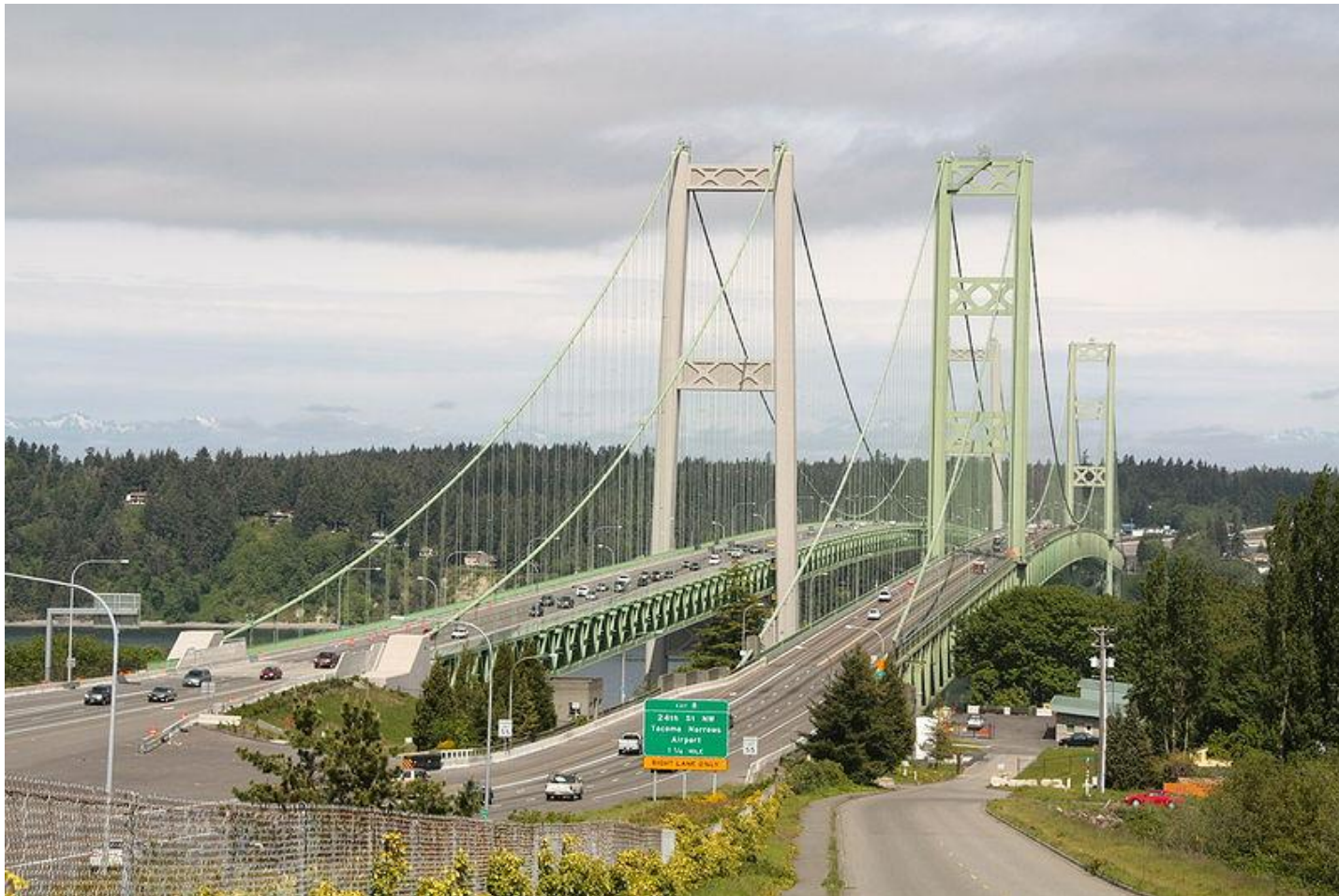
Tacoma (WA) Narrows Bridge, 1940
