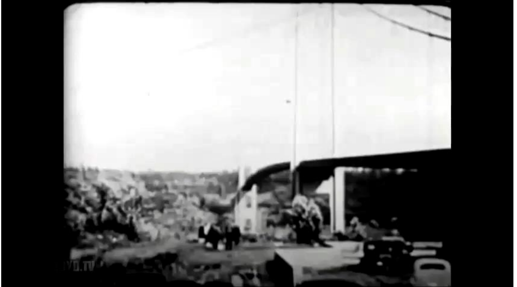
Tacoma (WA) Narrows Bridge, 1940
